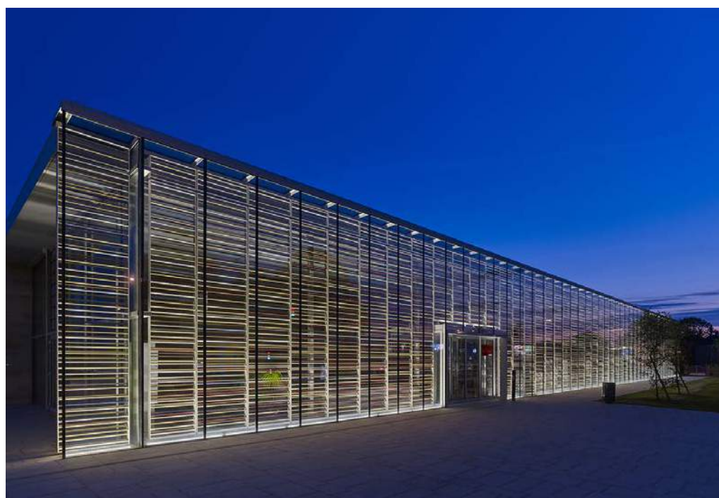
Médiathèque de Bayeux – Bayeux, France Architectural Project: SERERO Architectes Photo: Didier Boy de la Tour
